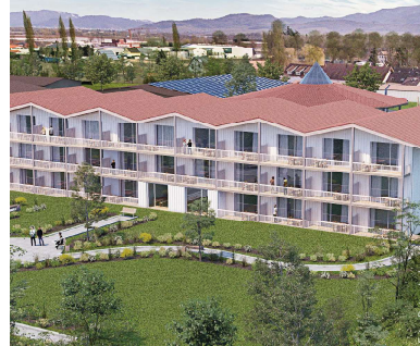
Bald fertig: Im September kommen die ersten Hotelgäste.
